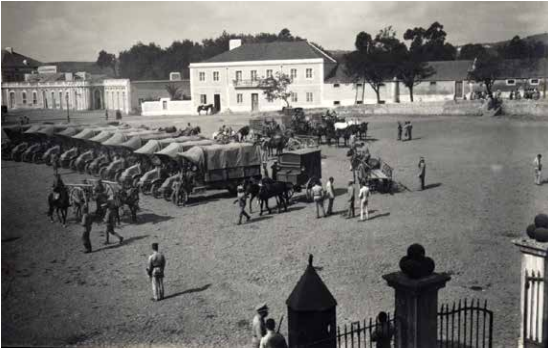
Figura 21 – A Praça da República, em frente ao Palacete, na altura do GBAC). 43
