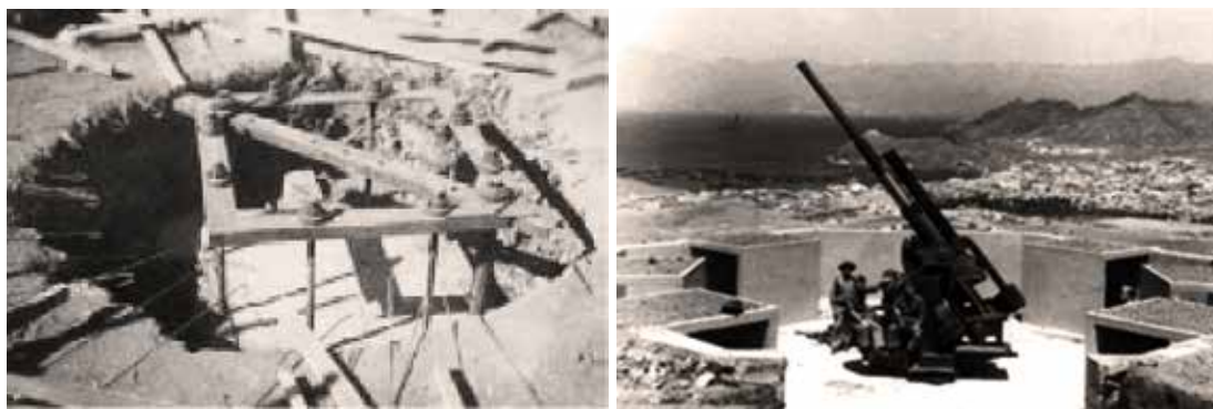
Figura 51 – Construção da posição da Peça 9,4 cm. Peça 9,4 cm em construção e em posição. 104
