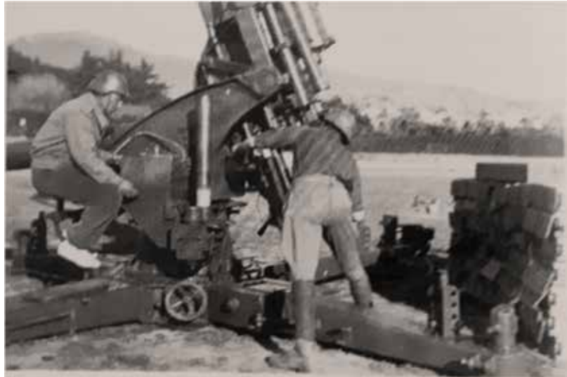
Figura 193 Material de Artilharia Antiaérea (AA) 8,8 cm. Graduação de espoleta (antes do carregamento da Peça). 296
