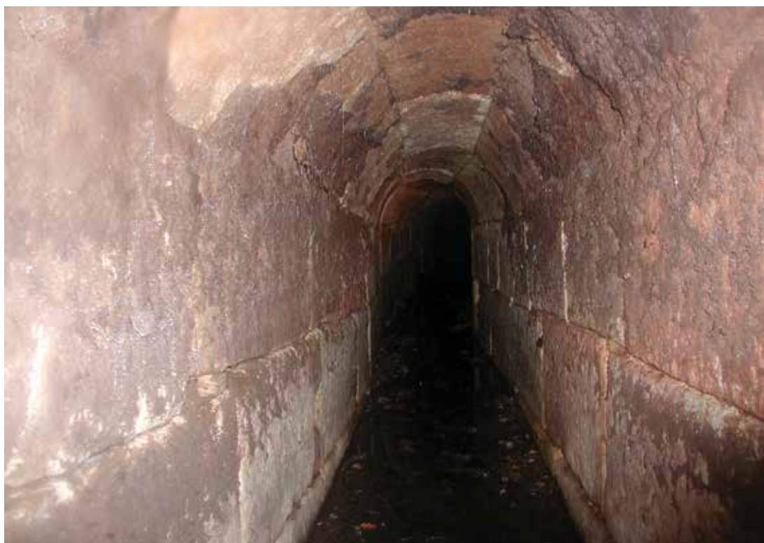
Figura 20 – Imagem das galerias subterrâneas. 42
